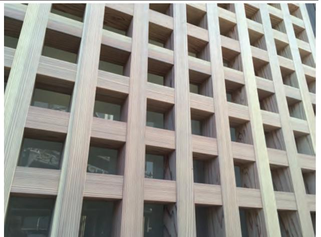
「格子戸」に見えるのは、新しい本堂を支える堅牢な「構造壁」です。残念ながら開放は出来ませんが外光を堂内に取り込み、季節や時の移ろいを感じることが出来ます。CLTパネルによる「木造のビル」を建築したウィルブプロジェクトの知見を活用し、文化財登録目前で罹災した本堂のイメージを崩さずに新しい表情を持たせています。この格子細工は単純な仕口ではなく、補強のために専用の治具を開発して造作しています。興味のある方はじっくり調べてみてください。
